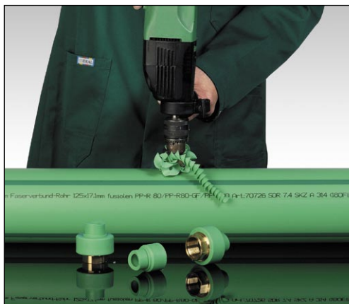
Genomborring av rörväggen
