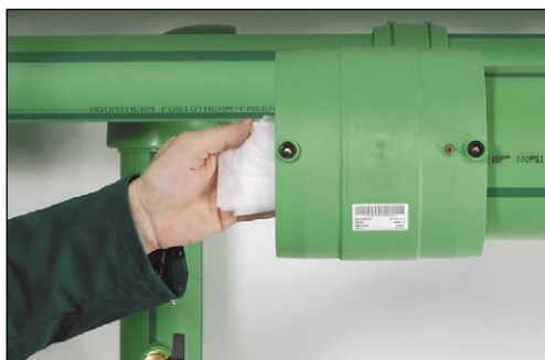
Rengör elektrosvetsmuffen igen
